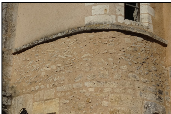
L'appareillage en épis de blé du XI e de l'absidiole sud.
